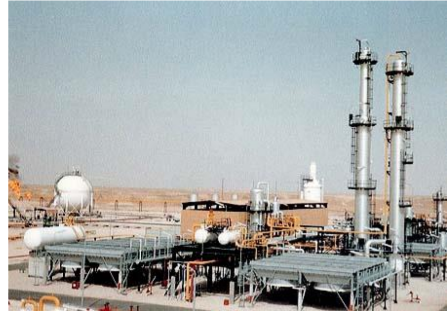
オアグラのプラント建設現場
